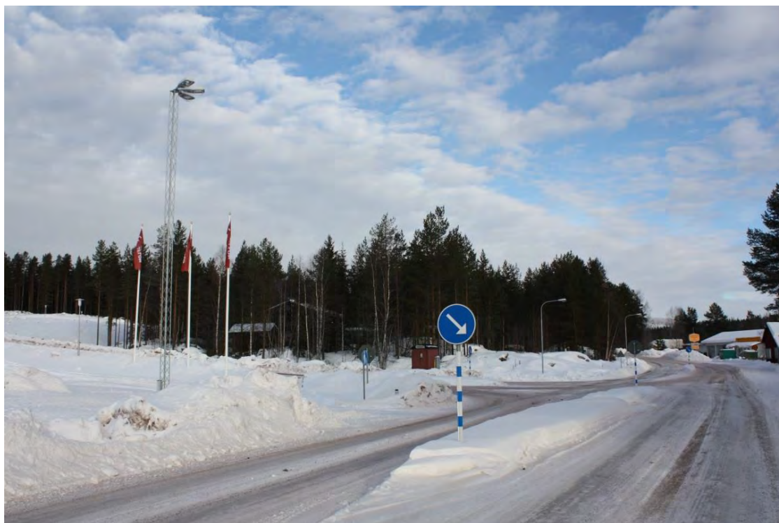
Bild 1: Nyligen byggt vägsäl enligt den tidigare detaljplanen. I förgrunden syns den refug som skyddar gångpassagen. Vy mot norr från väg 62.
