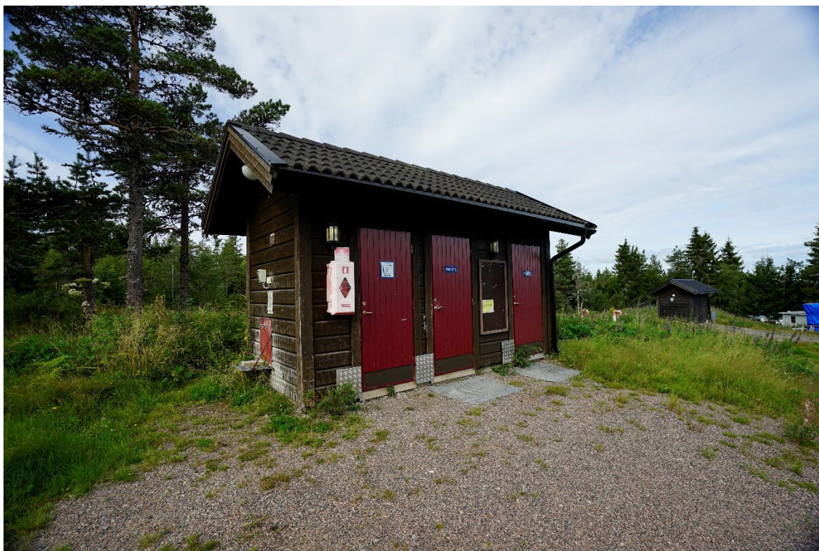
Toalettbyggnaden. Pumphuset skymtas nere till höger
