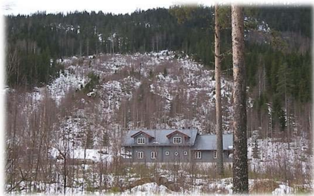
Figur 5. Servicebyggnad sedd från öster.
