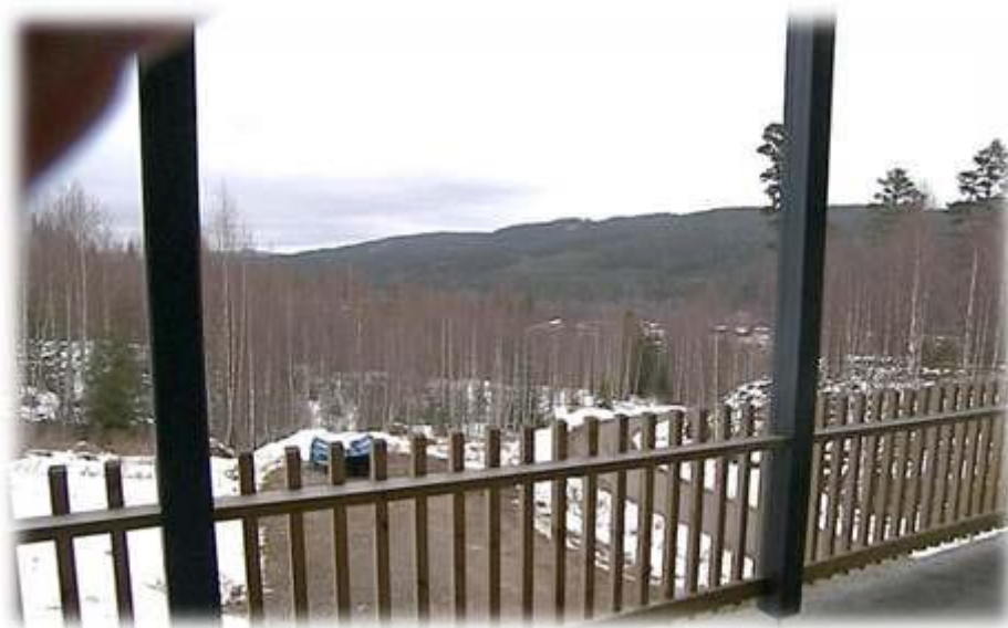
Figur 7. Ljungvägen ansluter i dalen och väggroppen är byggd upp till servicebyggnaden.
